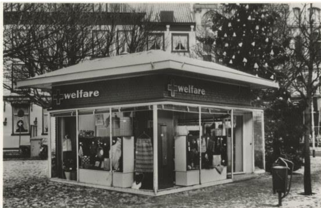
Kiosk aan de Hofweg, hoek Lange Poten
